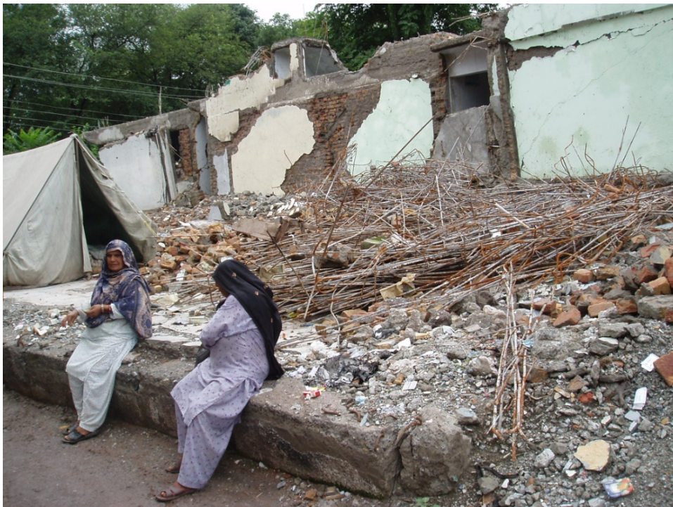
Fotografía 2. Parte vieja de la ciudad, cerca de ruinas antiguas. Ladrillos standard. 30-70 años de antigüedad. El edificio original era de 3 pisos de alto; sólo quedan partes de la pared trasera. Las vigas de metal no eran parte del edificio original que colapsó. Terreno plano.
