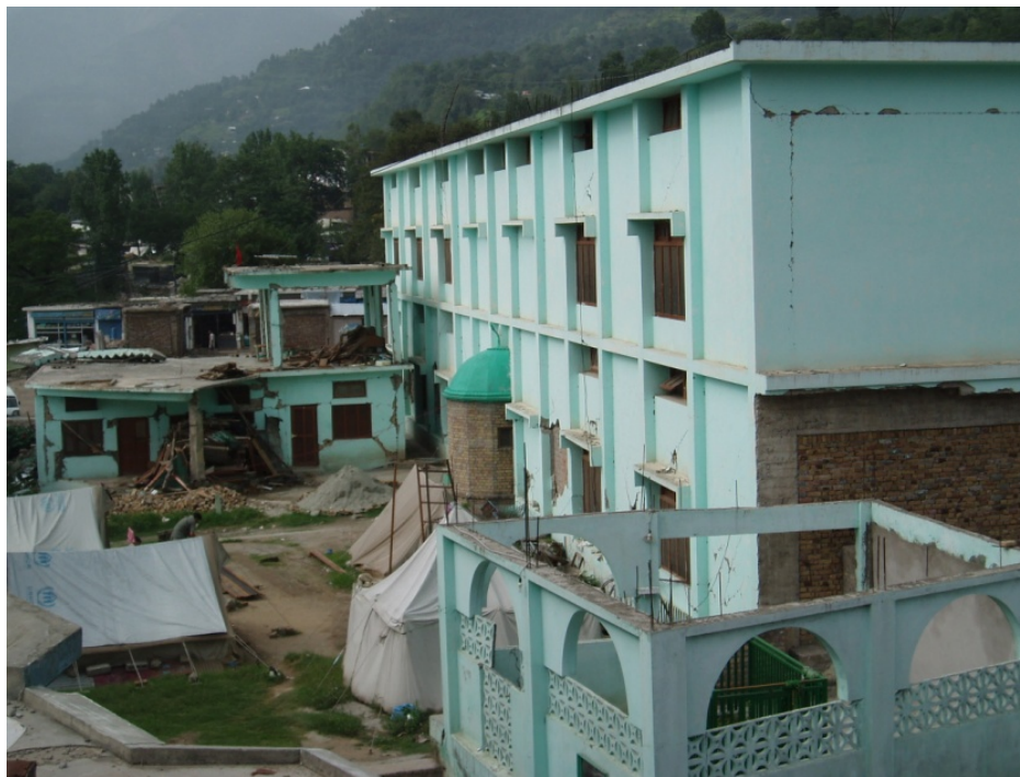
Fotografía 6. Orilla este del área residencial cerca de las montañas. Terreno plano. Todos los edificios azules fueron construidos por la misma compañía con métodos similares. Daño estructural mínimo, un poco de daño en las paredes.
