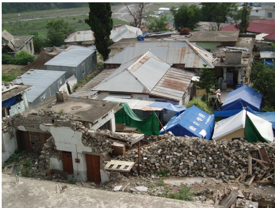
Fotografía 7. Orilla occidental del área residencial, cerca del río. Terreno plano. EL edificio de metal colapsó casi completamente. Daño estructural mínimo en los edificios de metal. 10- 30 años de antigüedad.
